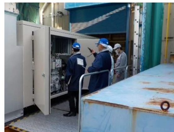
c 非常用発電機の製品検査（製作工場）
