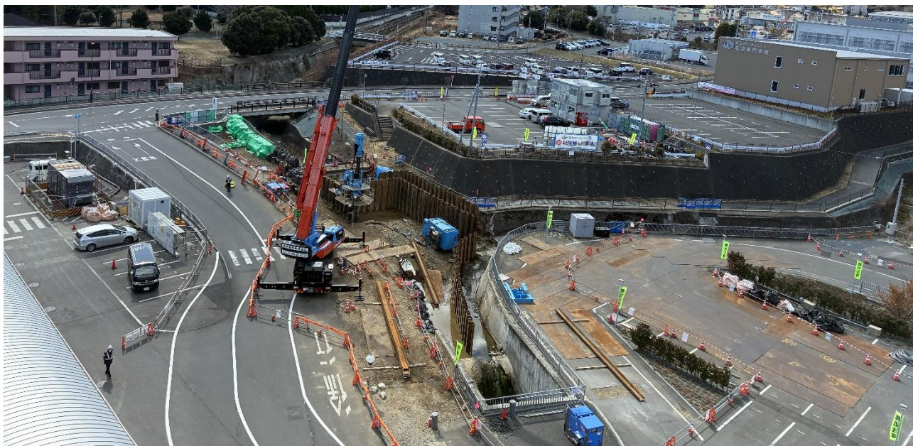
仮設土留めの設置状況（数沢川）
