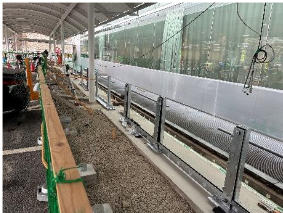
a 止水壁の設置状況（西側）
