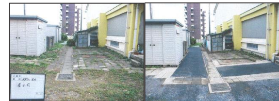
施行前 施行後 (河原子小防災備蓄倉庫)
