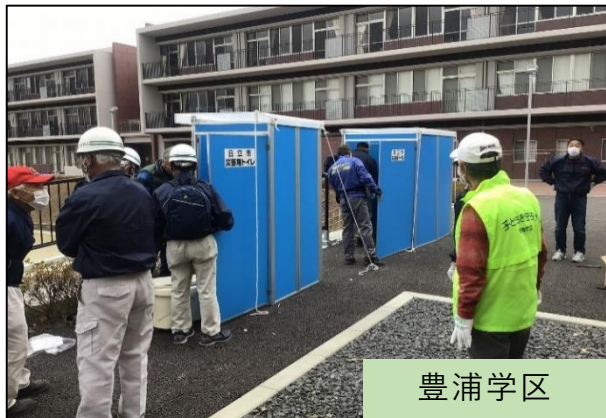
○マンホールトイレ設置訓練
