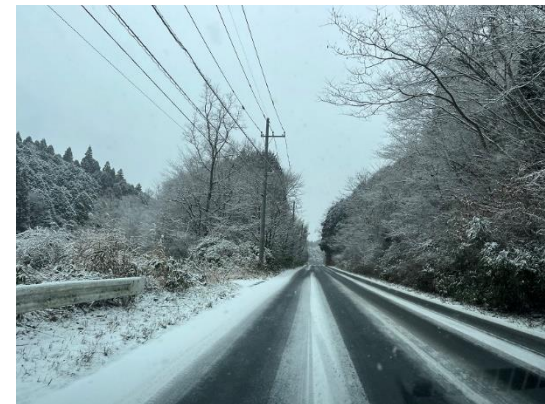
通行止めとなった広域農道
