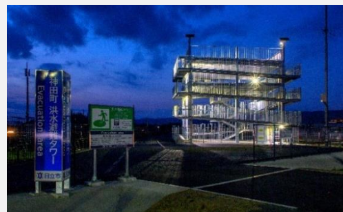
令和4年度に整備した神田町洪水避難タワー
