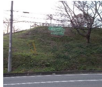
【本復旧工事後】
