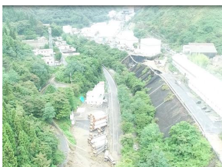
【県道日立山方線上空から】
