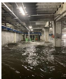
【処理場(地上階)の浸水】
