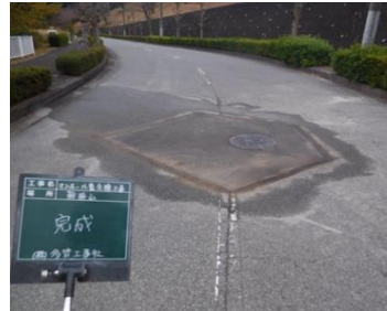
【本復旧工事後】
