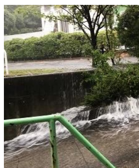
【東側車路への雨水流入】
