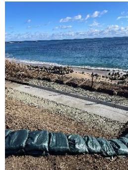
【本復旧工事後】
