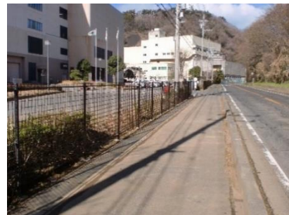
【本復旧工事後】
