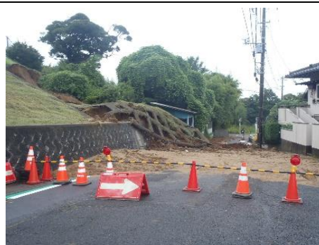
【水木小学校法面】
