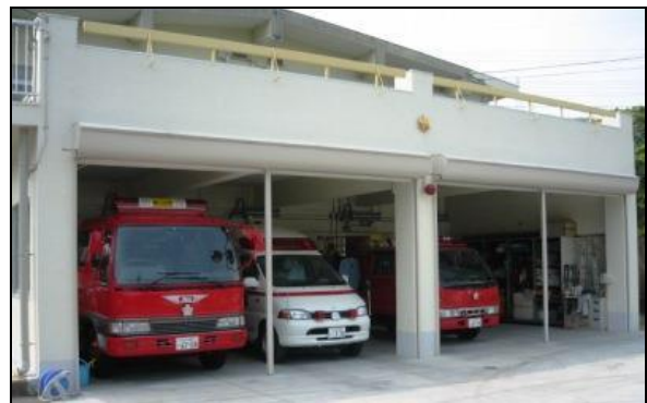
日立消防署西部機関員派出所
