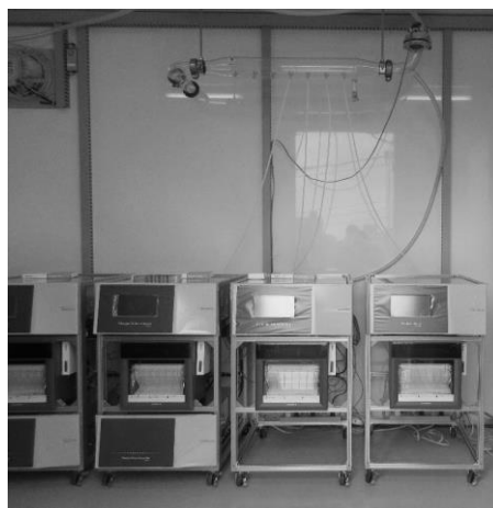
測定局舎内部の自動測定機
