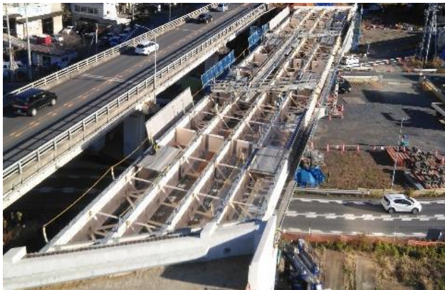
国道6号大和田拡幅事業
