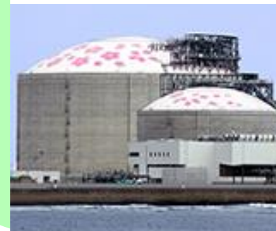
日立LNG基地
