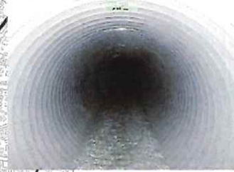
舟入川管更生 施工後
