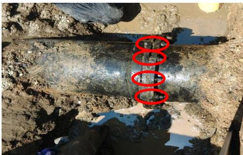
(水道管腐食対策：継手部の確認)
