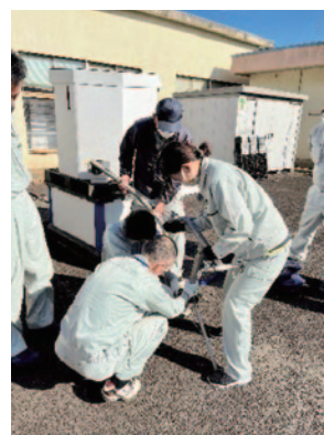
応急給水タンク設置研修
