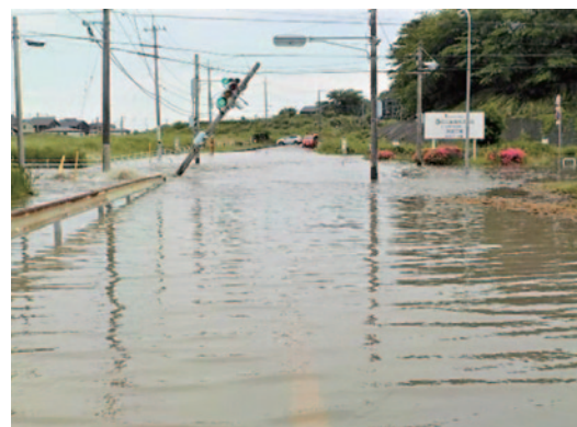
R2 砂沢町漏水の様子
