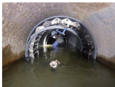
【寿命を延ばすための工事】
