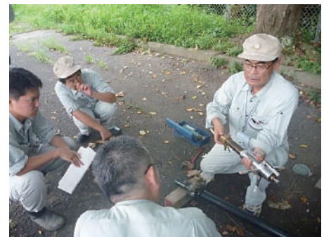
サドル分水栓穿孔作業研修
