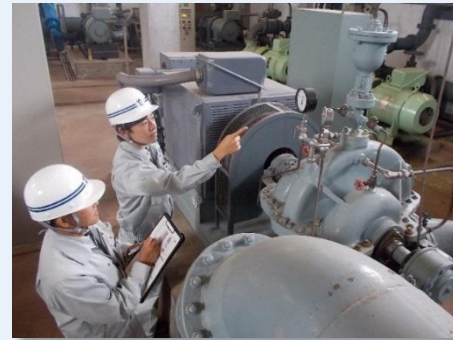
ポンプ設備点検
