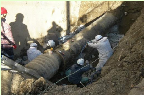
滑川中継ポンプ場圧送管破断修理
