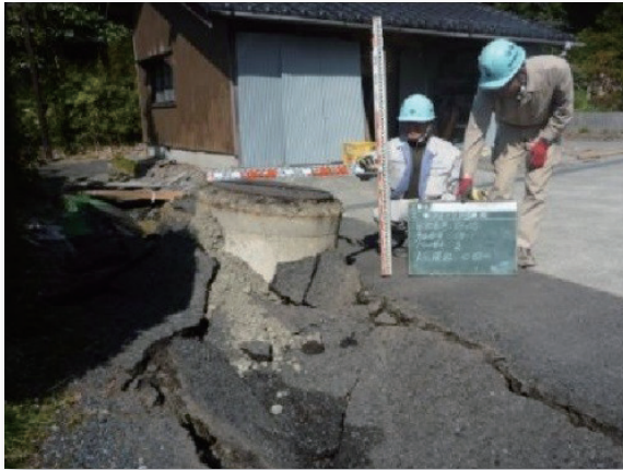
地震による被害(マンホール浮上)
