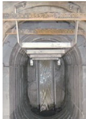
浮上防止(インナーウェイト工法の例)
