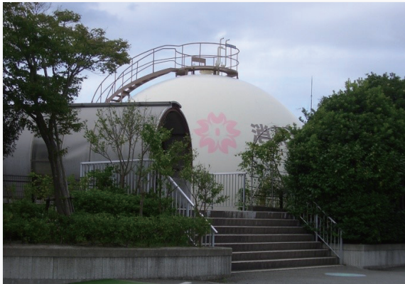
消化ガスタンク
