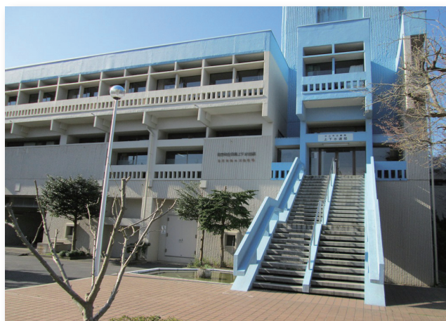
池の川処理場(管理棟)
