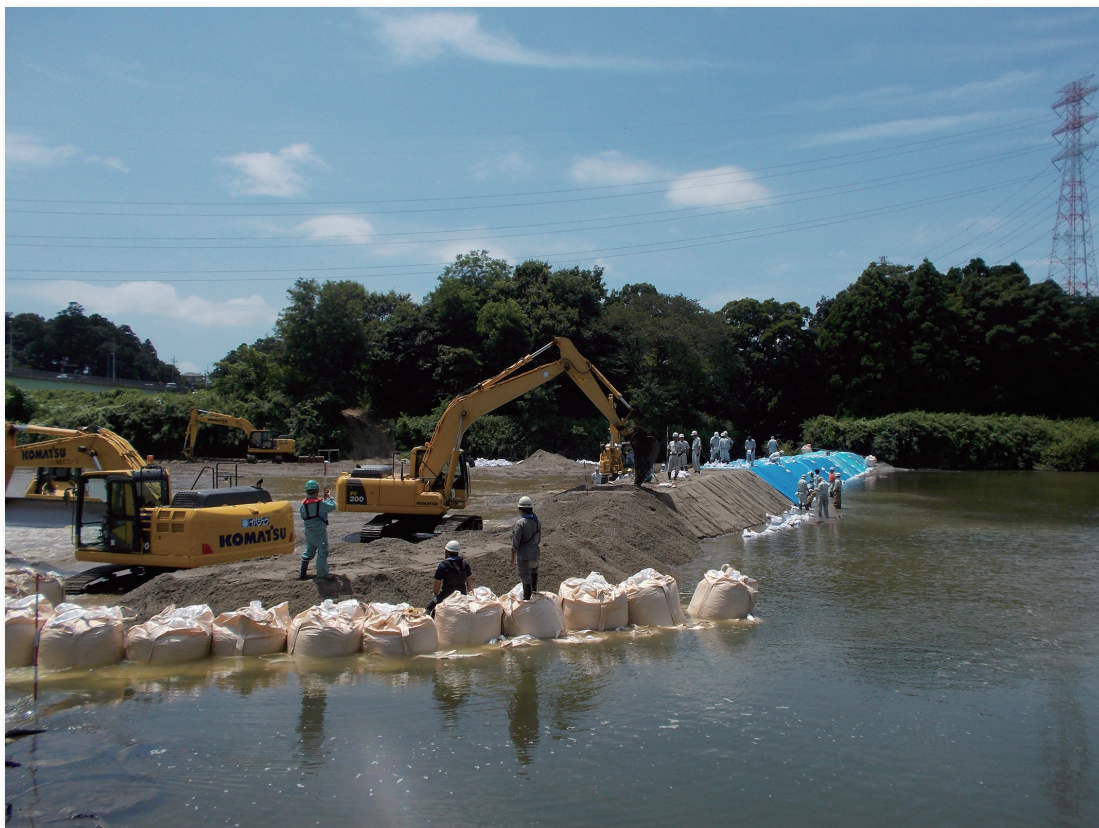
久慈川の土堰堤築堤作業
