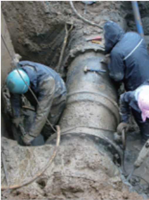
第2導水管漏水修理
