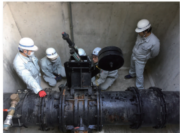
技術継承研修(サドル分水栓穿孔・配水池バルブ切替作業)
