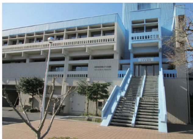
池の川処理場(管理棟)
