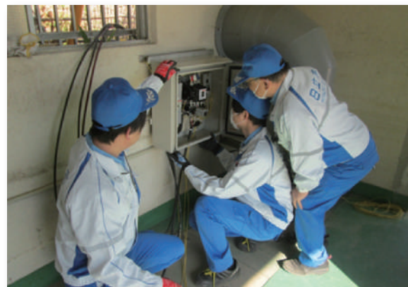
仮設制御盤設置訓練(会瀬ポンプ場)
