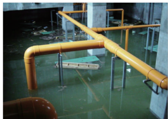
河原子中継ポンプ場(シャッター破損・電気制御室への浸水)
