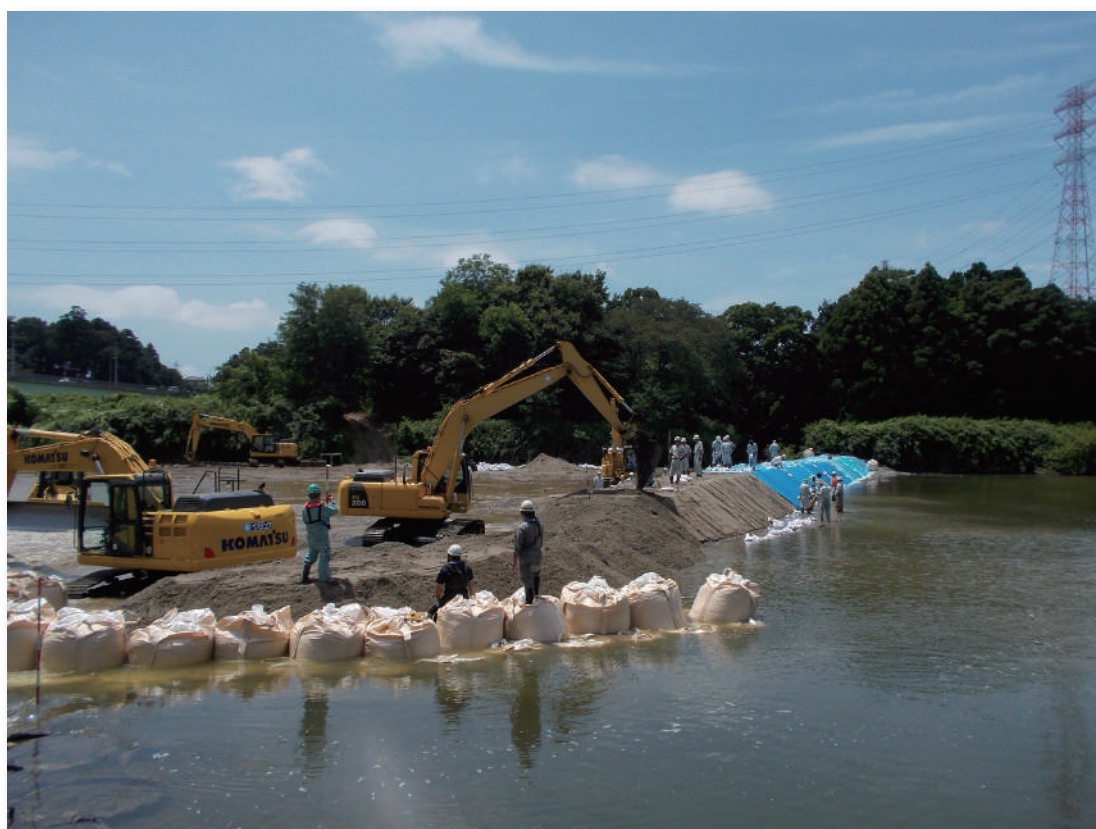
久慈川の土堰堤築堤作業
