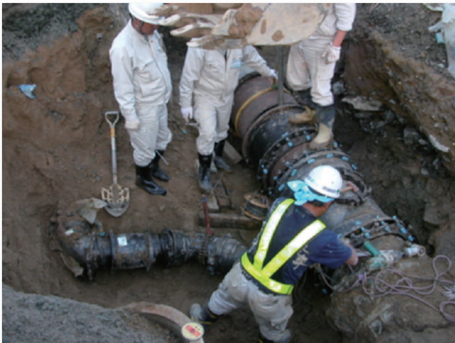
配水管漏水修理(小木津町)
