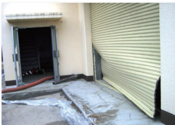
河原子中継ポンプ場(シャッター破損・電気制御室への浸水)
