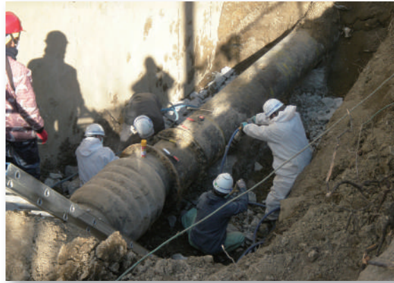
滑川中継ポンプ場(圧送管の破断修理)
