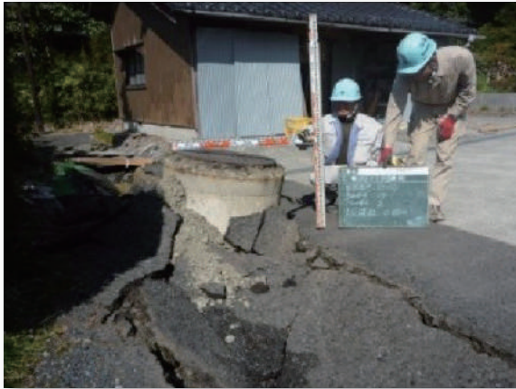
地震による被害(マンホール浮上)
