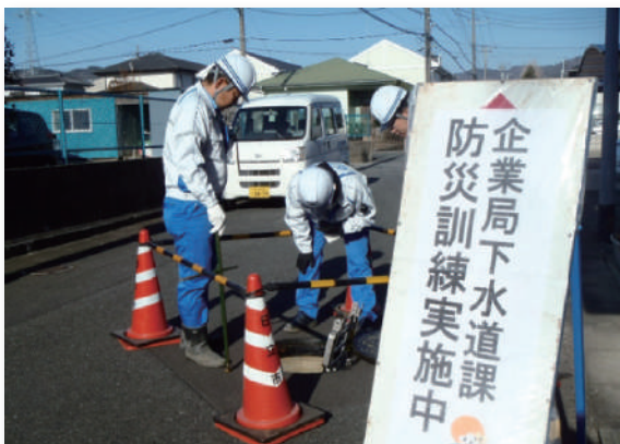
マンホール内目視点検訓練
