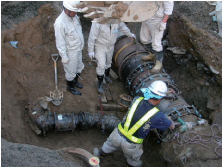
配水管漏水修理(小木津町)
