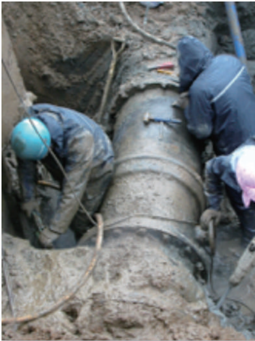
第2導水管漏水修理
