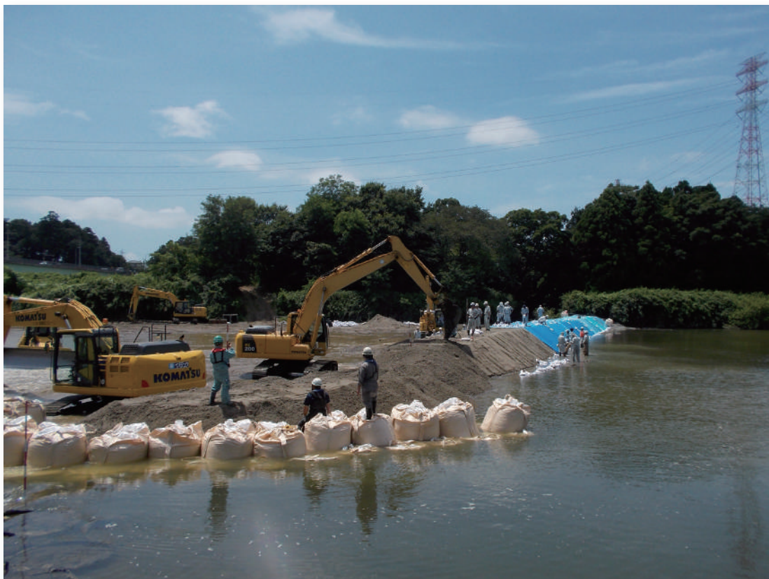
久慈川の土堰堤築堤作業
