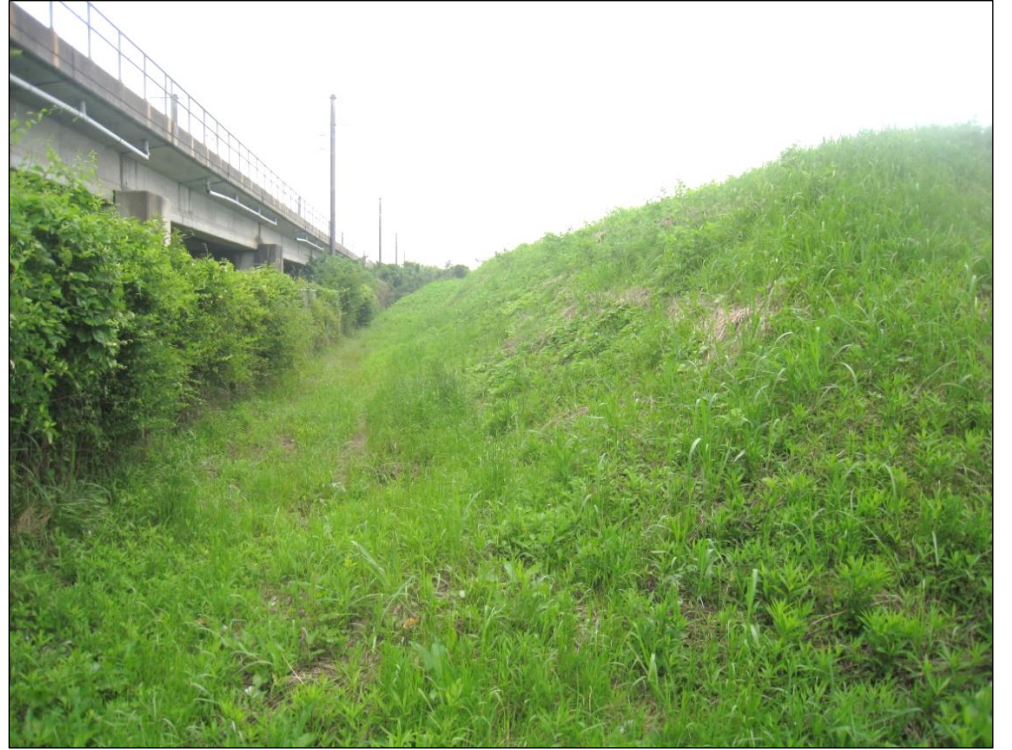
①西側法面（常磐線側）
