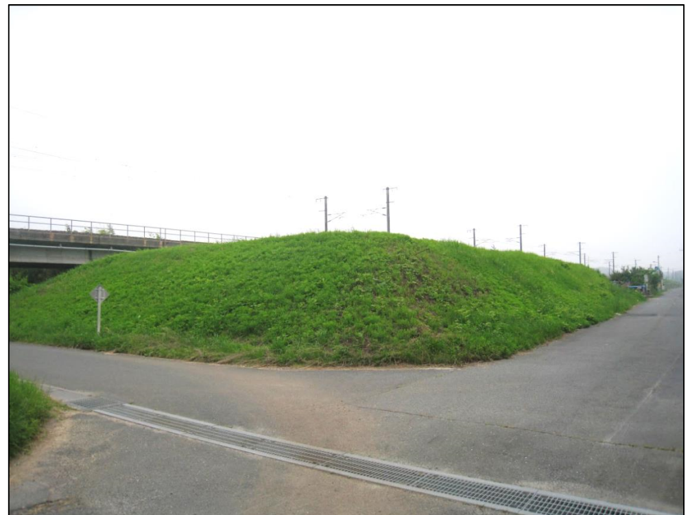
⑤南側法面
