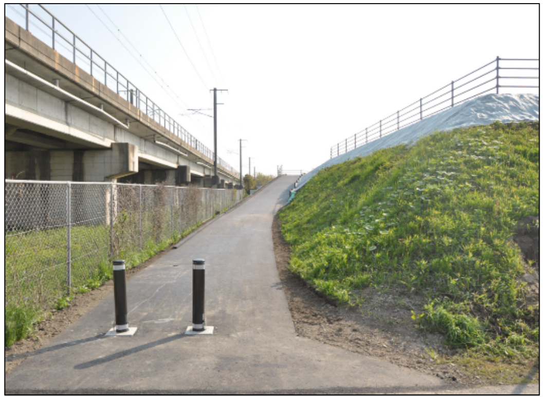
①西側法面（常磐線側）
