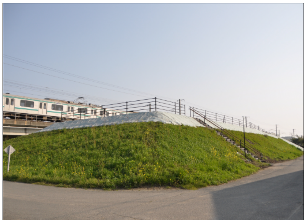
⑤南側法面
