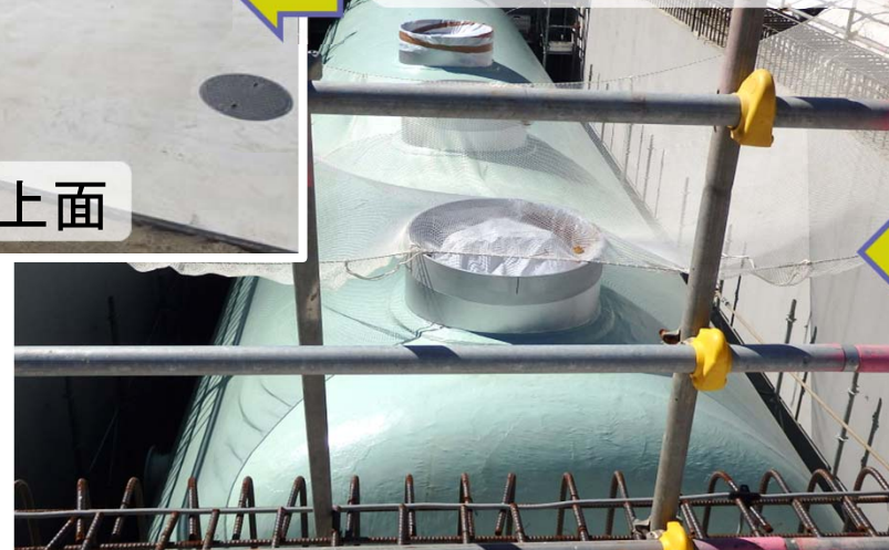
躯体工及び 重油貯蔵タンク設置
