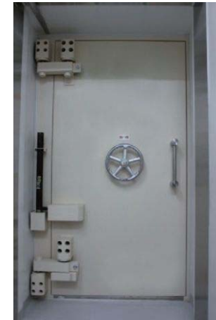
水密扉 (閉止状態)
