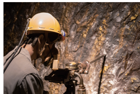
模擬坑道内で展示される「 もぎ こうどう 横坑掘進」 当時の作業現場を間近で体感することができます。
