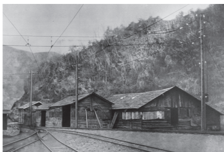
1910(明治43)年当時の「創業小屋」 日立鉱山の機械修理部門として設立されました。 (日立製作所 提供)
