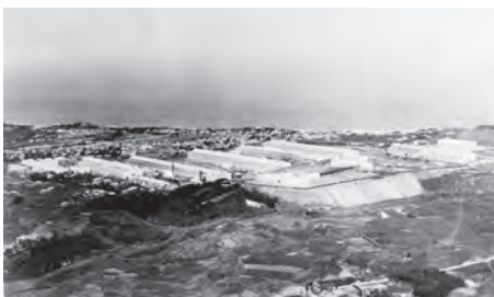
1935（昭和10）年頃の「海岸工場」工場建設に伴い、まちも急速に拡大していきました。（日立製作所 提供）
