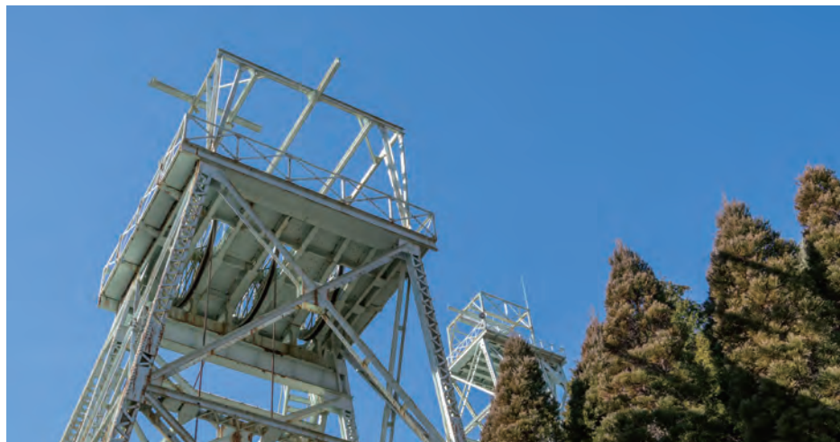
屋外の第一竖坑（手前）と第十一竖坑（奥）
