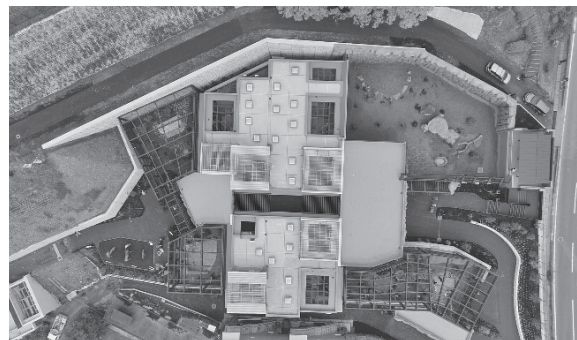
施設全景（上空から）
