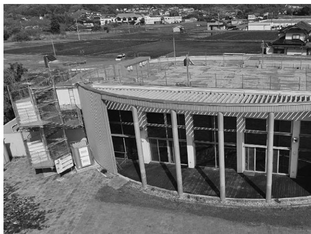
避難階段（久慈川日立南交流センター）
