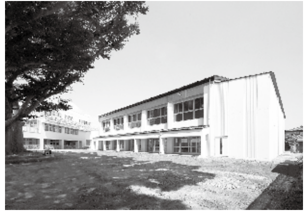
久慈小学校 屋内運動場
