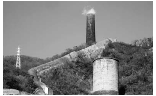
1914年(大正3年)に建てられた現在の大煙突(宮田町)
