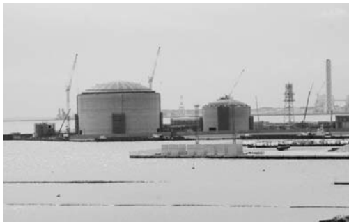
本格稼働に向け建設が進むLNG基地(留町)
