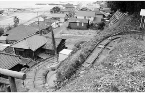
ソーラー式照明灯を設置する避難通路（会瀬町地内）
