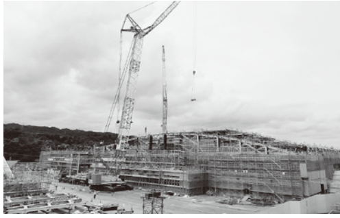
建設が進む池の川さくらアリーナ（東成沢町）
