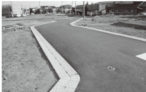
開発行為で新設された道路（鮎川町）
