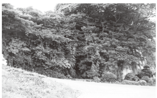
市内にある急傾斜地危険箇所
