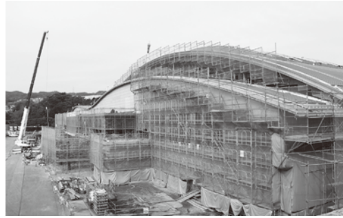
約8割が完成した池の川さくらアリーナ（東成沢町）
