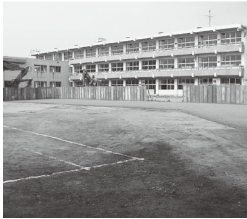
校舎等の改築工事が行われている久慈小学校
