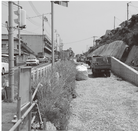
第Ⅱ期工事が進められているBRT専用道路（東大沼町）
