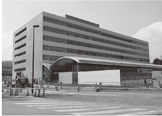
第1期本体工事が完了した市役所新庁舎
