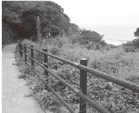
遊歩道などの再整備が望まれる東滑川海浜緑地
