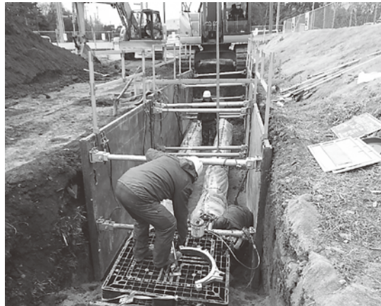
地震に強い水道管への更新工事を進めている
