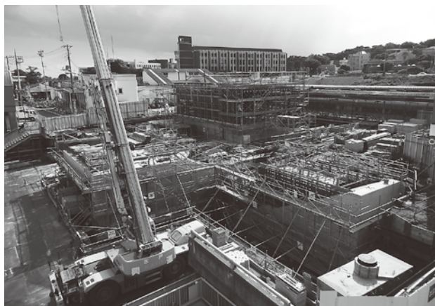
駅舎及び東西自由通路の工事が進められている大甕駅
