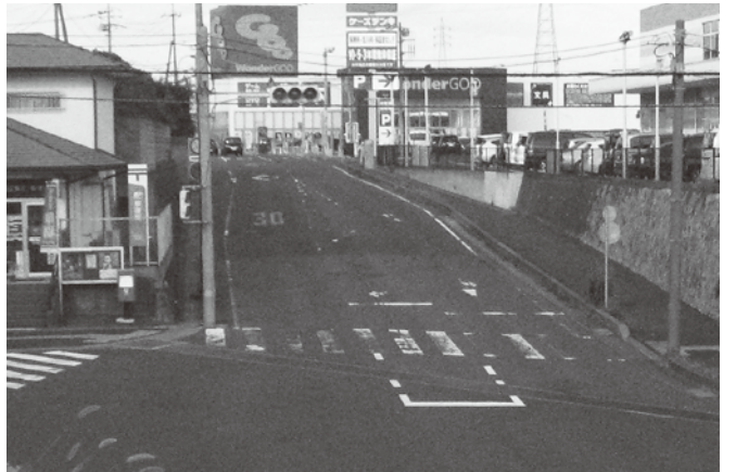
茨城国体開催に向けて整備する市道路線(鮎川町)
