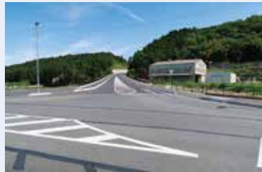
砂沢バイパス(令和2年3月開通部分)
