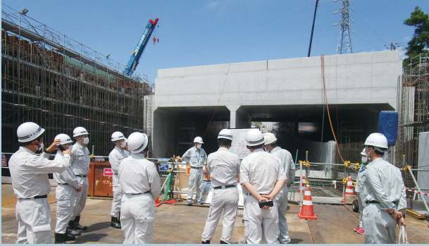
鮎川停車場線(JR常磐線アンダーパス工事)
