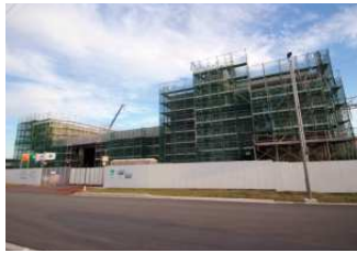
建設中の南部消防署
