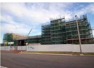
建設中の南部消防署
