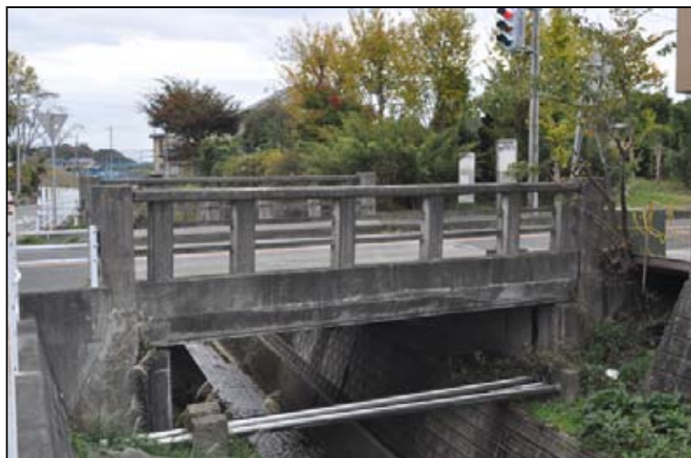
その他の橋りょう（折笠橋）
