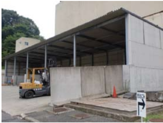
ストックヤード全景
