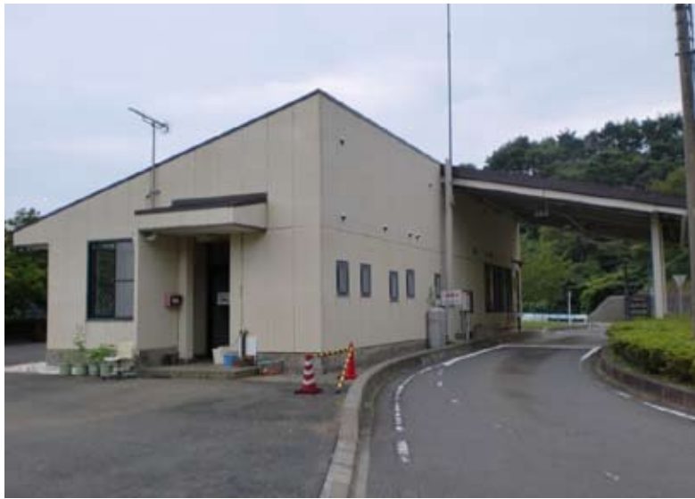
事務所(計量所)全景
