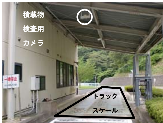
計量機(トラックスケール)
