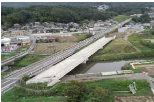
【4車線化が進む国道6号（石名坂町）】
