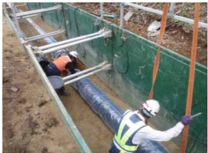
【水道管路耐震化等工事】
