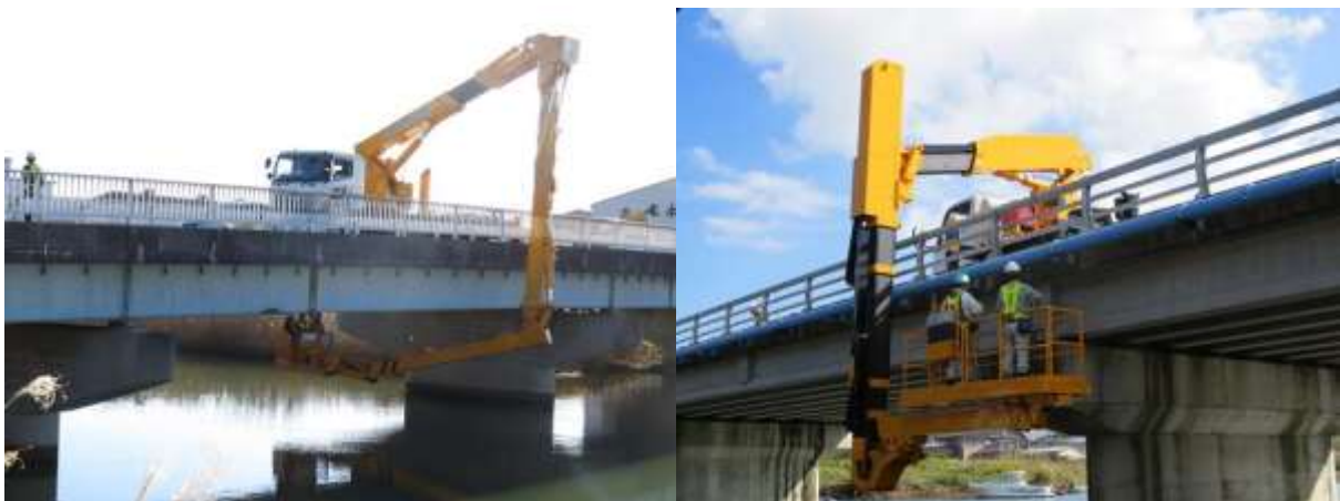
【橋梁の点検状況】
