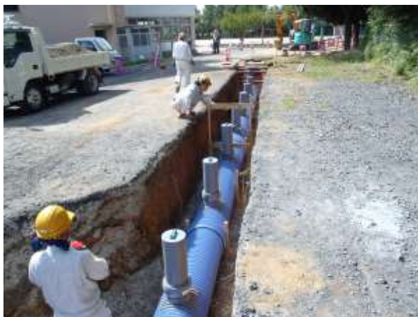
【マンホールトイレ整備】
