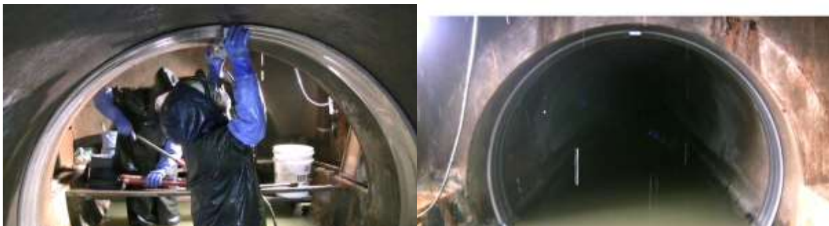
【下水道管渠耐震化工事】
