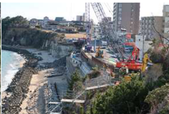
【4車線化が進む国道245号（水木町）】
