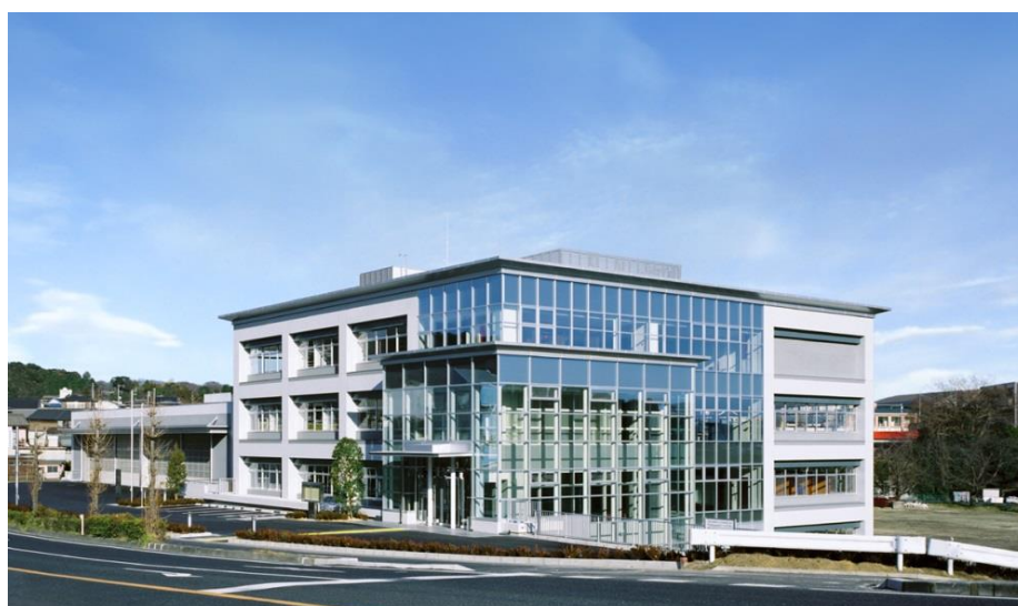
【消防拠点施設】
