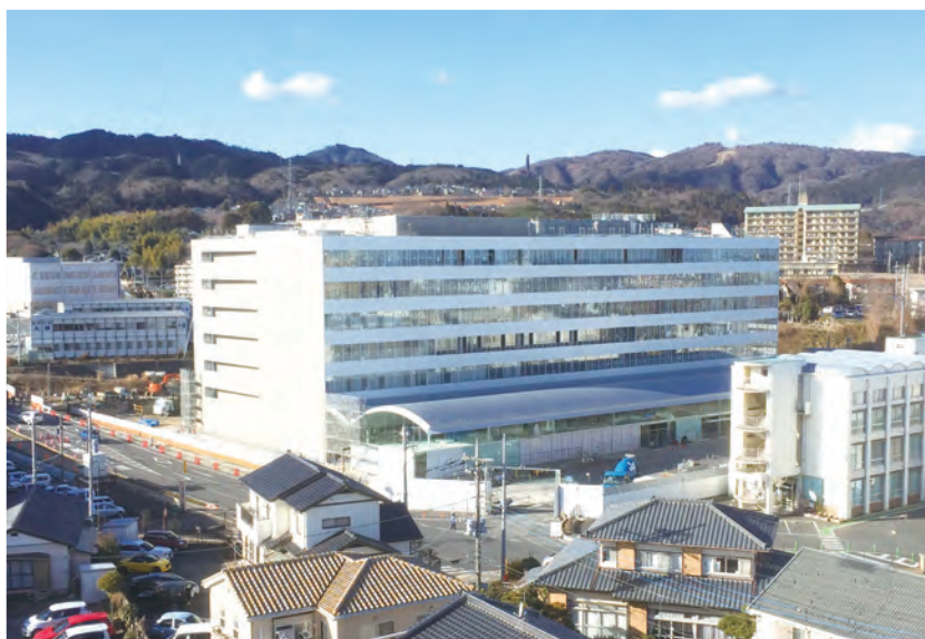
建設中の日立市新庁舎
