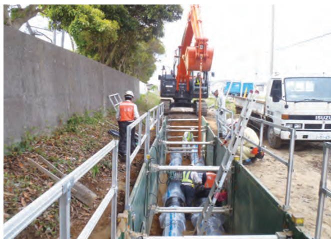
水道管路更新工事
