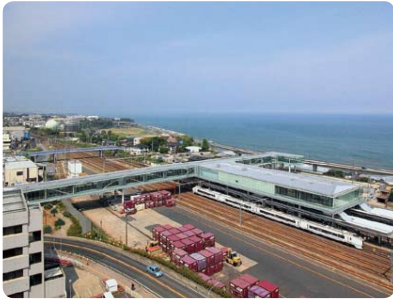
日立駅自由通路及び橋上駅舎
