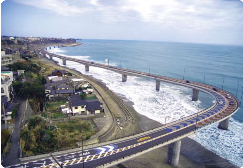
国分町まで延伸される国道6号日立バイパス（旭町付近）
