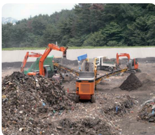
災害廃棄物の処理（滑川山処分場）
