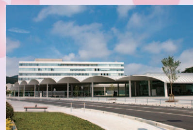
⑦ 日立市役所新庁舎
