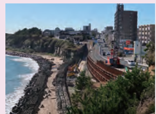
国道245号日立港区北拡幅事業
