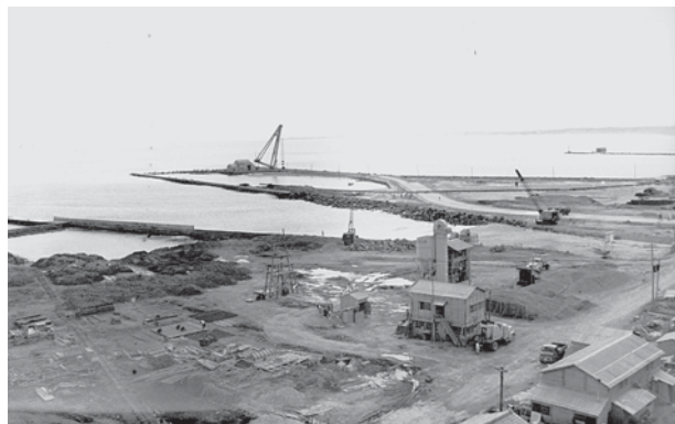
▲建設中(昭和34年)
