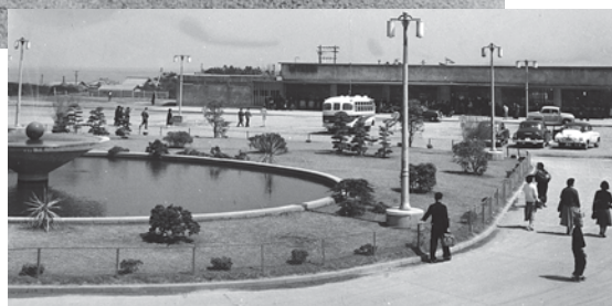
舗装後の日立駅前広場▶ (昭和27年)
