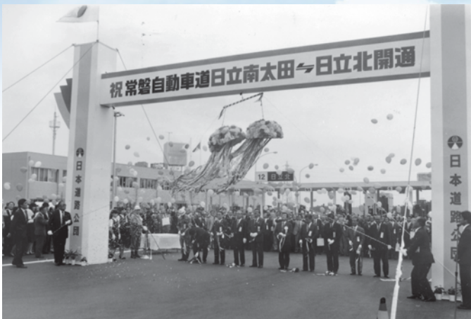
▲1985年(昭和60年)常磐自動車道日立北インターチェンジ開通
