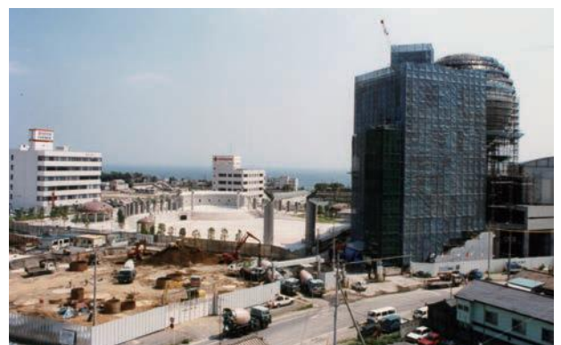
▲建設中の日立シビックセンター(平成2年)
