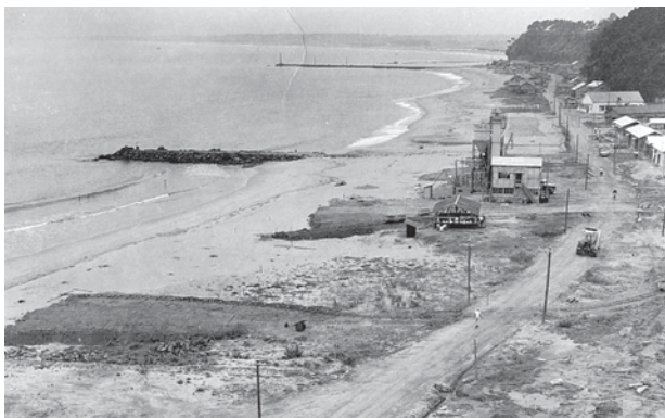
▲着工時(昭和32年7月)
