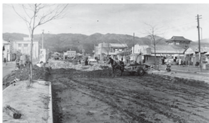
▲舗装中の平和通り(昭和29年)
