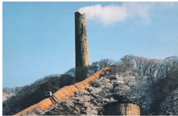
▲倒壊した後の大煙突(平成5年)
