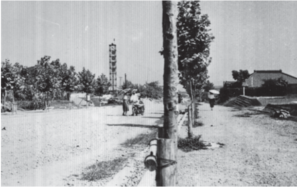
▲常陸多賀駅前大通り(現在のよかっぺ通り) (昭和30年頃)(鉄塔は建設中の常陽銀行)
