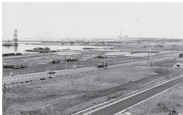
▲国道245号と日立港(昭和62年)
