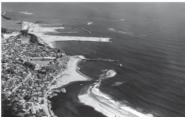
▲完成した岸壁(昭和35年)
